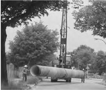
Transport eines Stahlrohres zum Rohrgraben
