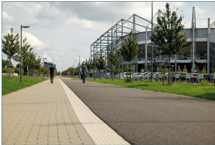
Radschnellweg am Nordpark in Mönchengladbach (Foto: ZVLG)
