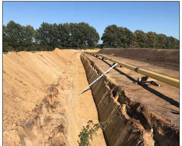
Abbildung 13: Rohrgraben und Leitung (DN 300 im Bild)
