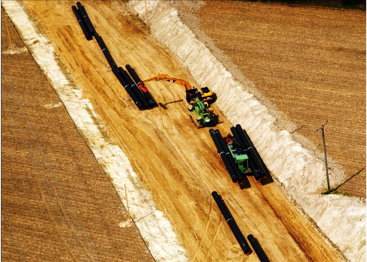
Abbildung 11: Rohrausfuhr im Arbeitsstreifen
