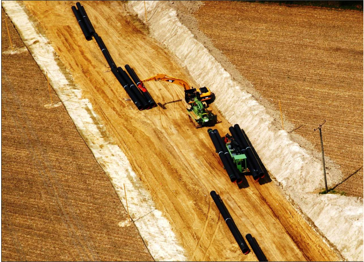
Abbildung 11: Rohrausfuhr im Arbeitsstreifen
