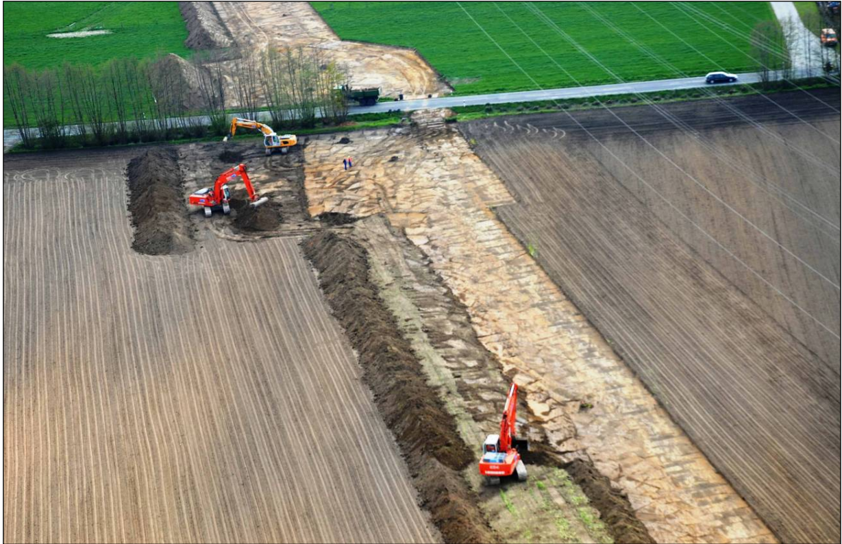
Abbildung 10: Abtragen und Lagern des Oberbodens
