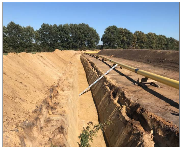
Abbildung 13: Rohrgraben und Leitung in DN 300
