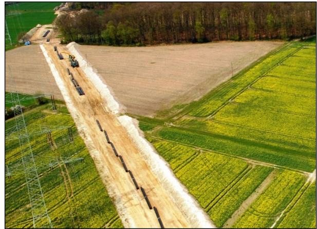
Abbildung 6: Arbeitsstreifen in freier Feldflur
