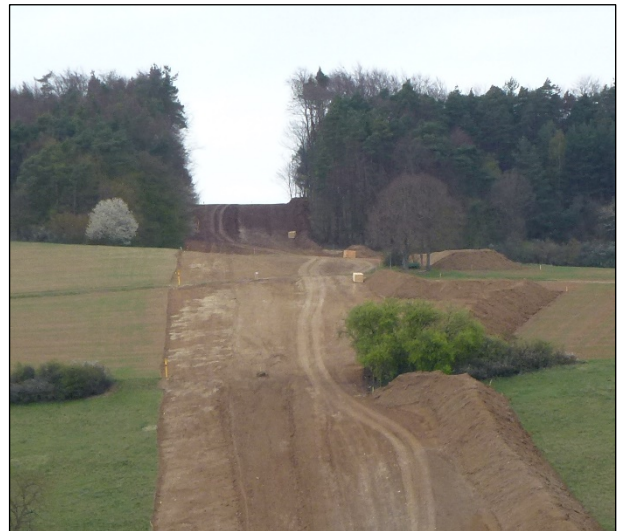
Abbildung 7: Arbeitsstreifen im Wald (Einengung / Aufweitung)
