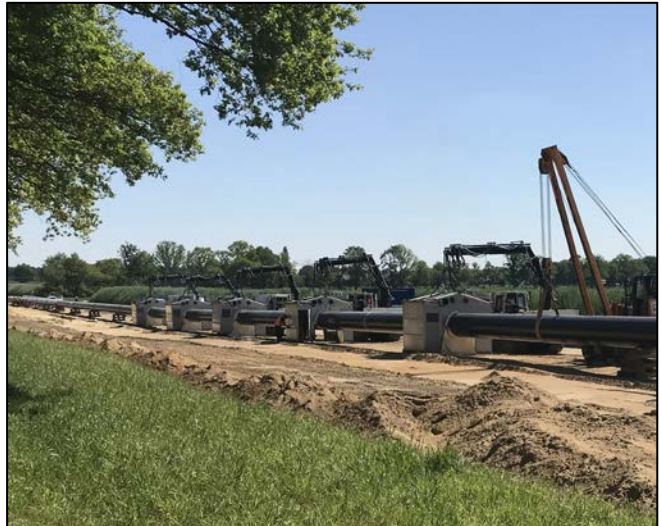
Abbildung 12: Schweißzelte (Ltg. DN 1.000)
