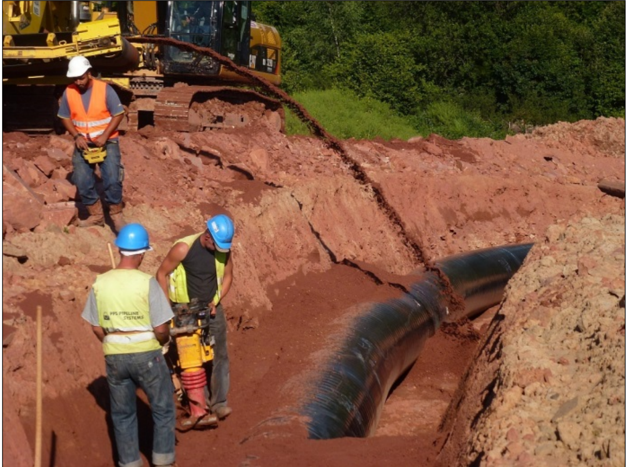
Abbildung 15: Verfüllen des Rohrgrabens (Ltg. im Bild mit DN 1.000)
