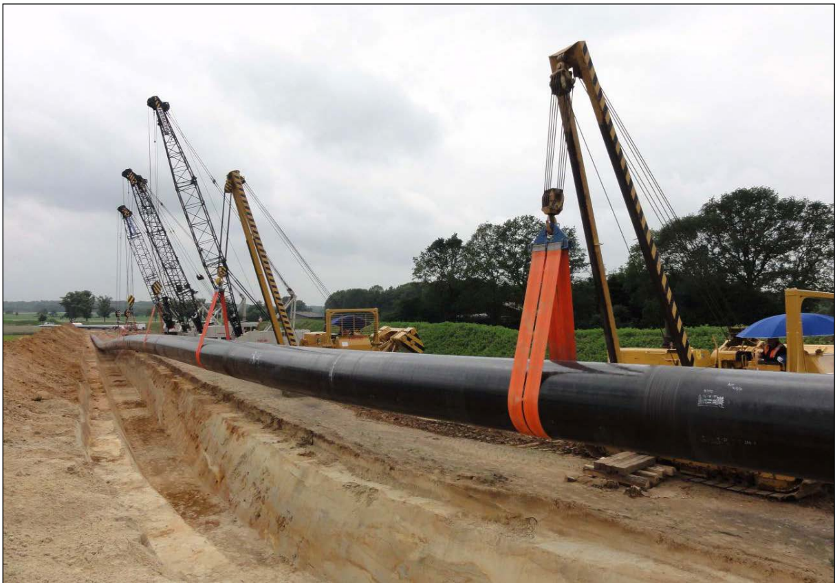
Abbildung 14: Absenken des Rohrstranges (Ltg. im Bild mit DN 1.000)
