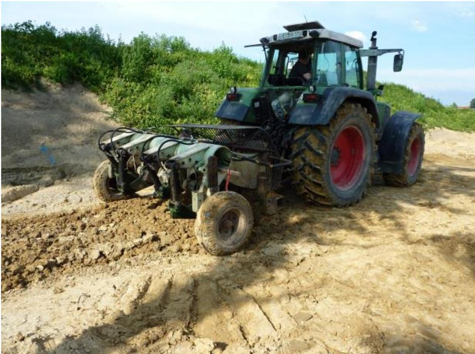
Abb. 3-12: Maßnahmen zur Bodenlockerung, Quelle: OGE
