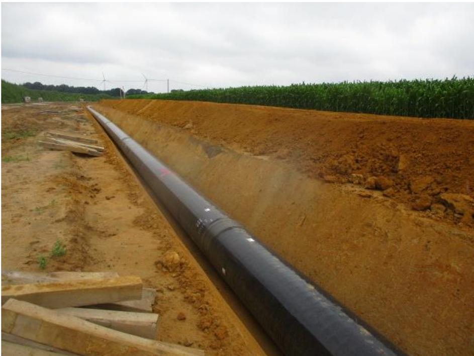
Abb. 3-11: In den Rohrgraben abgesenkter Rohrstrang, Quelle: uventus
