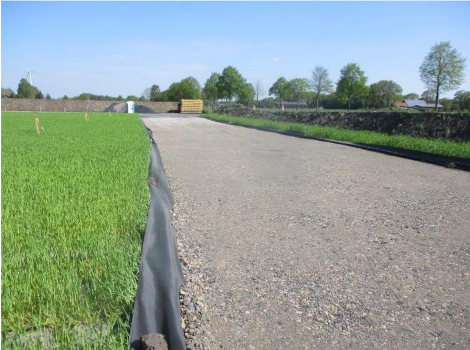
Abb. 3-6: Baustraße aus Schotter mit unterlegtem Vlies, Quelle: uventus
