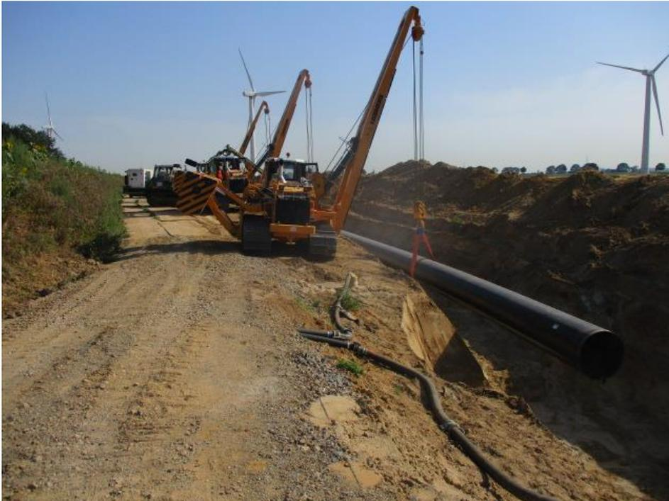
Abb. 3-10: Absenken des Rohrstrangs, Quelle: uventus
