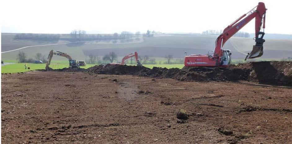
Abb. 3-4: Anlage eines Arbeitsstreifens, Quelle: OGE
