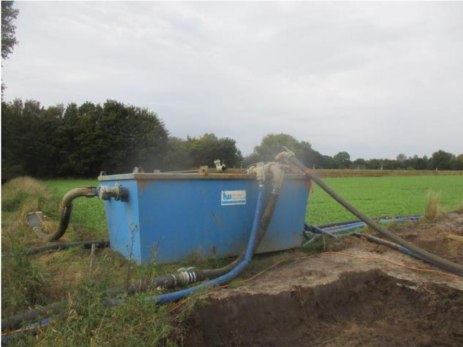
Abb. 3-8: Absetzbecken für die Wasserhaltung, Quelle: uventus
