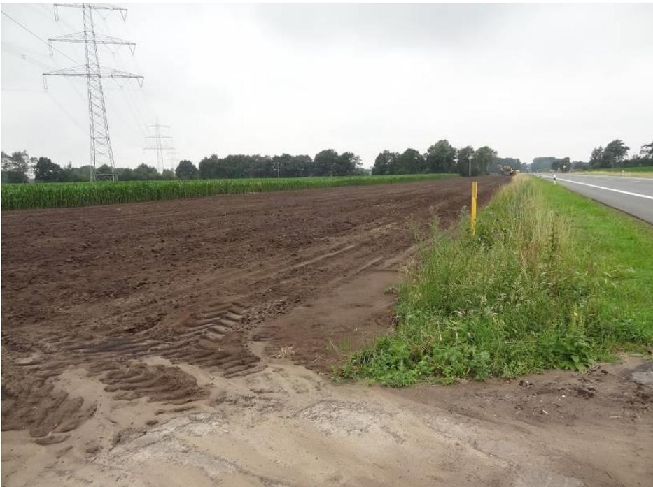
Abb. 3-13: Mit Mutterboden angedeckter Arbeitsstreifen, Quelle: uventus
