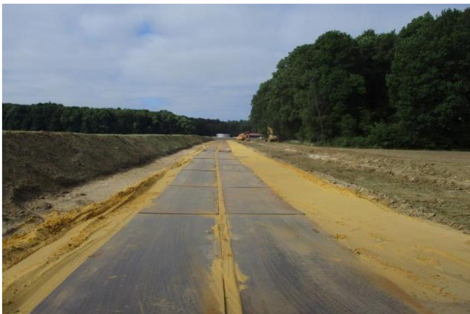
Abb. 3-5: Arbeitsstreifen mit Baustraße aus Stahlplatten auf Sandunterbau, Quelle: uventus
