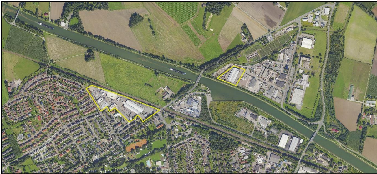
Abbildung 1: Derzeitige Betriebsstandorte - Luftbild
