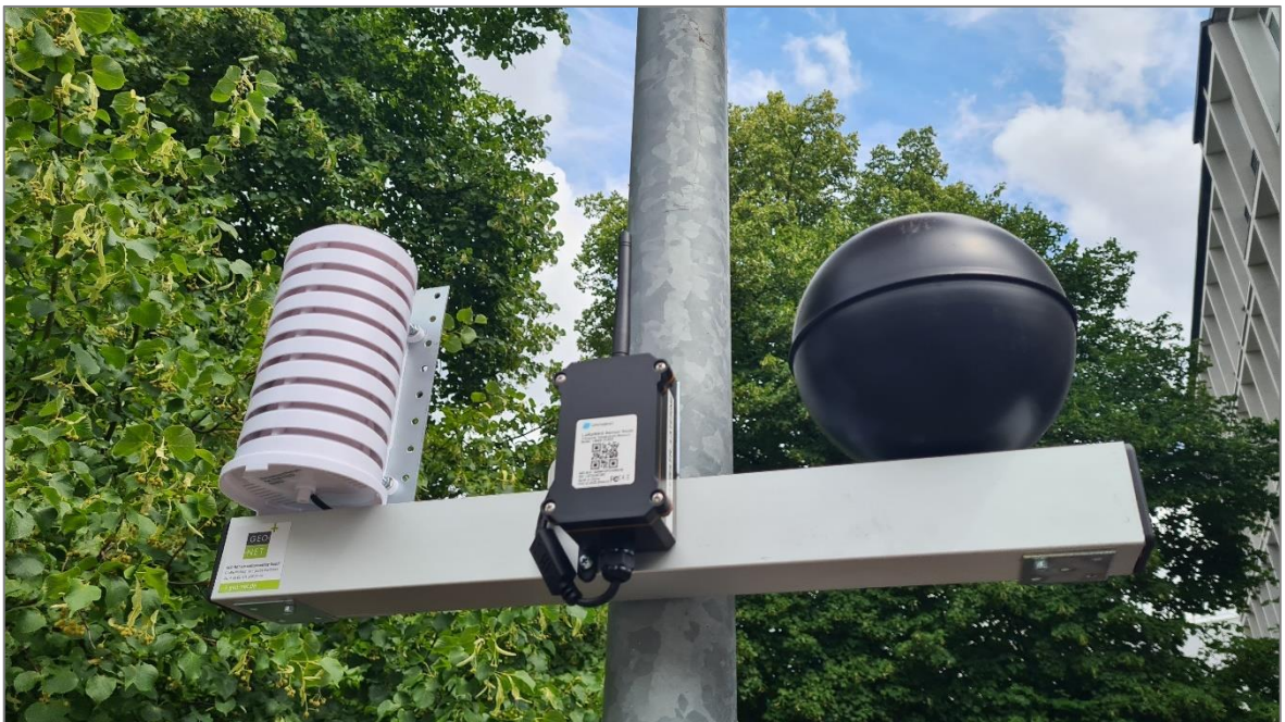
Abbildung 13: Beispiel einer kompakten Klimamessstation mit Temperatur und Globe-Temperatur auf zwei entgegengesetzten Auslegern (Quelle: Smart-City Hannover, eigene Aufnahme GEO-NET, 2023).
