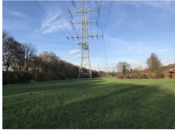
Bestand - Blick Richtung Norden
