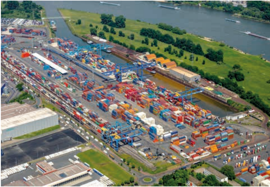
Neueste Mobilfunktechnik: Mit dem 5G.Smart.Logport soll im Duisburger Hafen die sichere und teilautomatisierte Steuerung von Containerkränen durch 5G-Technik untersucht werden.
