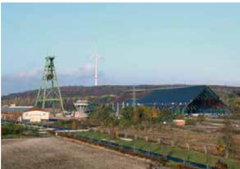
Windkraftanlage auf der Halde Lohberg Nord und Solareindeckung der Kohlenmischhalle in Dinslaken
