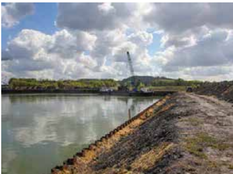
Baumaßnahmen auf der Fläche der Wasserstadt Aden in Bergkamen
