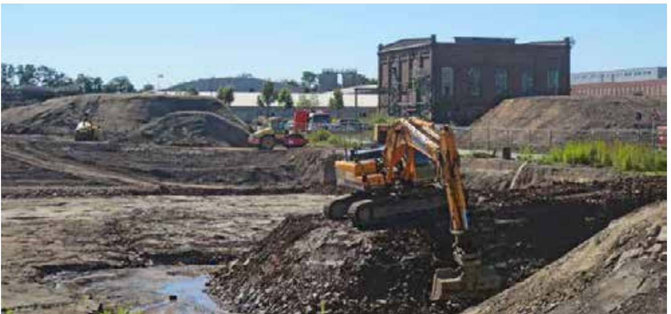
Baumaßnahmen auf der Teilfläche B des Geländes Gewerblische Mitte Recklinghausen Blumenthal in Recklinghausen
