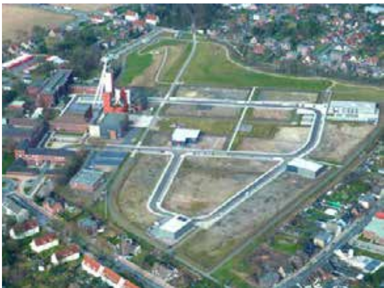
Luftaufnahme des Geländes von Schlägel & Eisen in Herten
